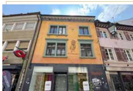
Sanierungsbedürftiges Wohn- und Geschäftshaus in der Freiburger Altstadt
